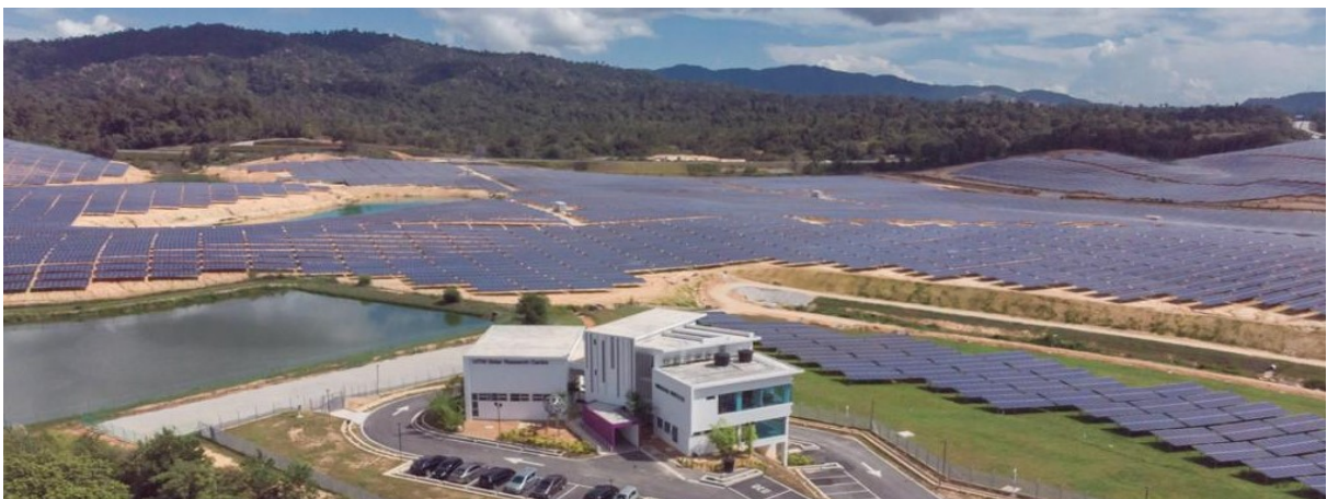
60MW LSSPV Plant, Gambang
