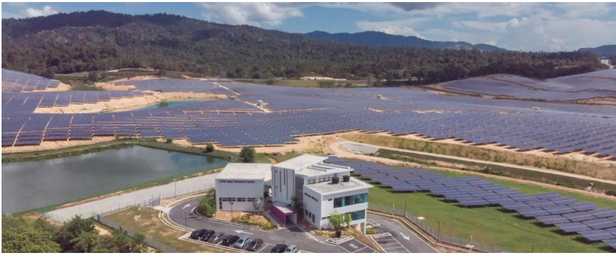
Stesen Janakuasa Solar Berskala Besar (LSSPV) berkapasiti 60MW, Gambang
